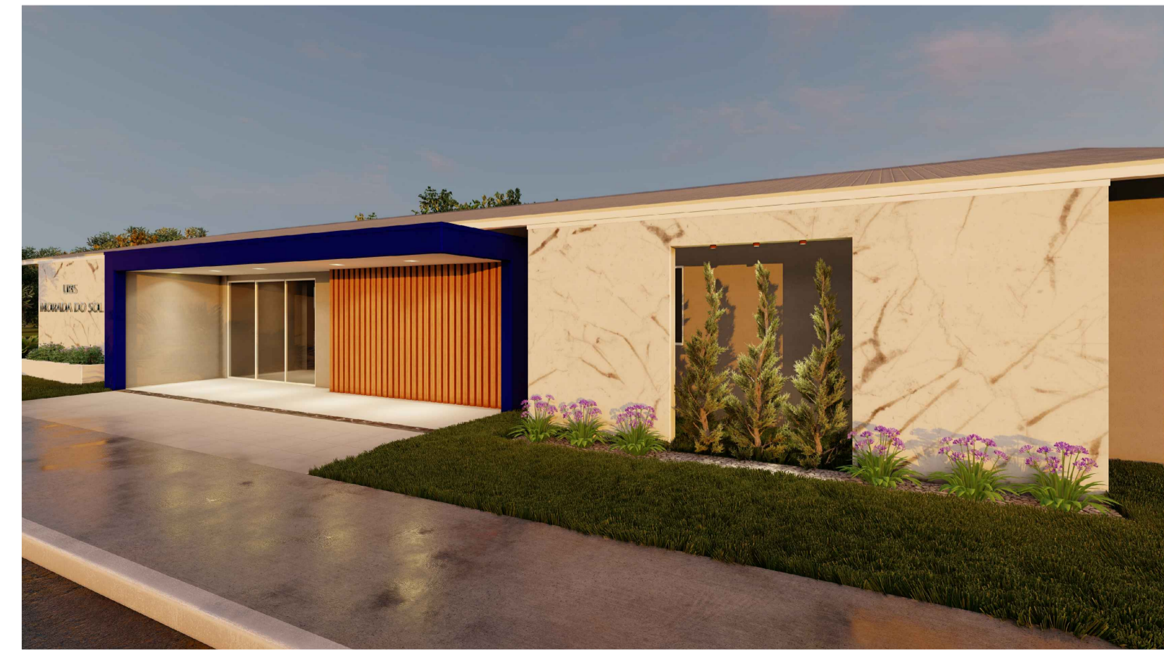
IMAGEM EDIFICAÇÃO PÓS REFORMA
