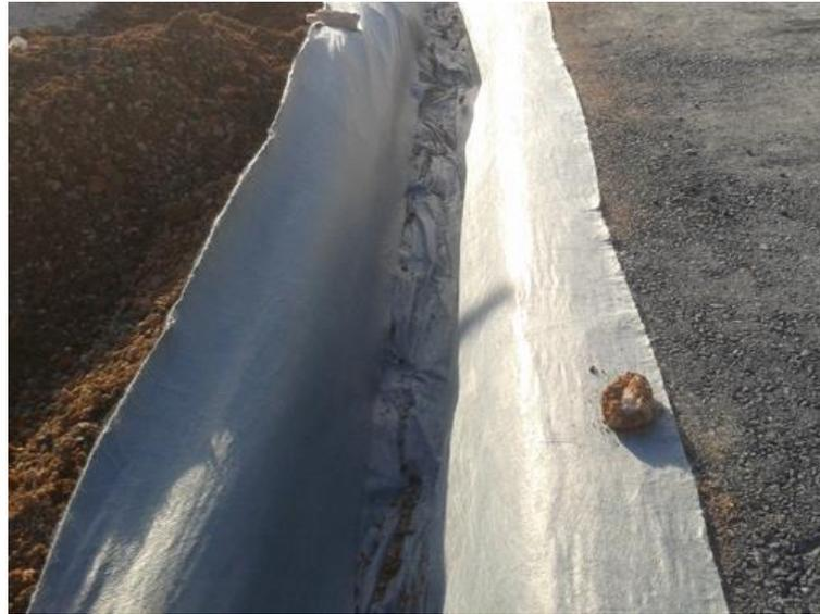
Deve ser colocada brita 19mm (brita 01) no fundo, formando uma camada de 10cm ao longo de toda a vala. Em seguida coloca-se o tubo dreno perfurado e completa-se toda a vala com brita, fechando toda a vala.
