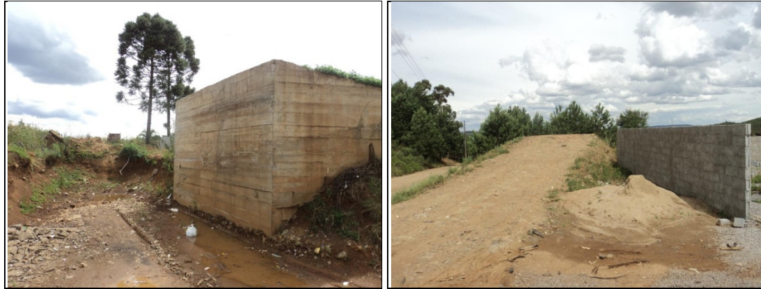
Figura 14 – Unidade de Transbordo no Município de Campos Novos SC.
