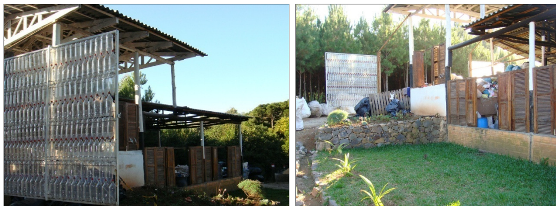
Figura 12 – Centro de Triagem Localizado no Município de Celso Ramos.
