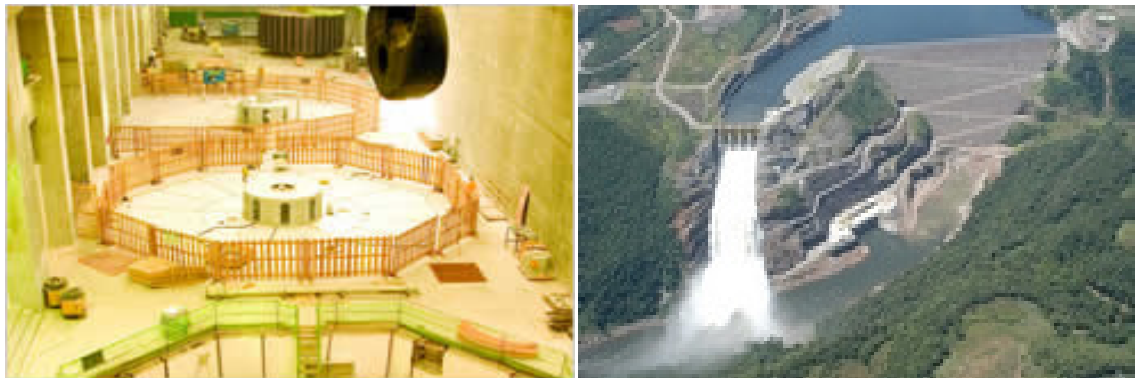
Figura 7 – Usina Hidrelétrica Campos Novos
